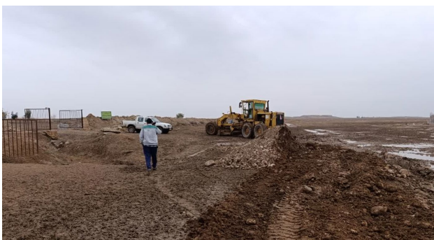
احداث جاده دسترسی ایستگاه تحقیقات شوری
